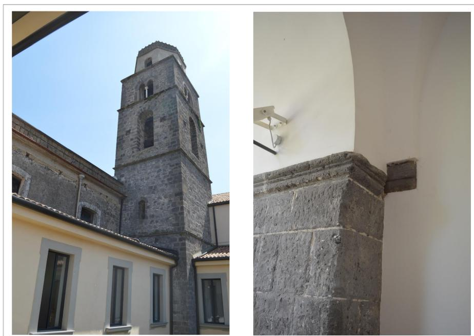
Fig. 5. Torre campanaria (quarta fase). A destra: dettaglio dello scarico della volta parzialmente coperto dal basamento del campanile.
